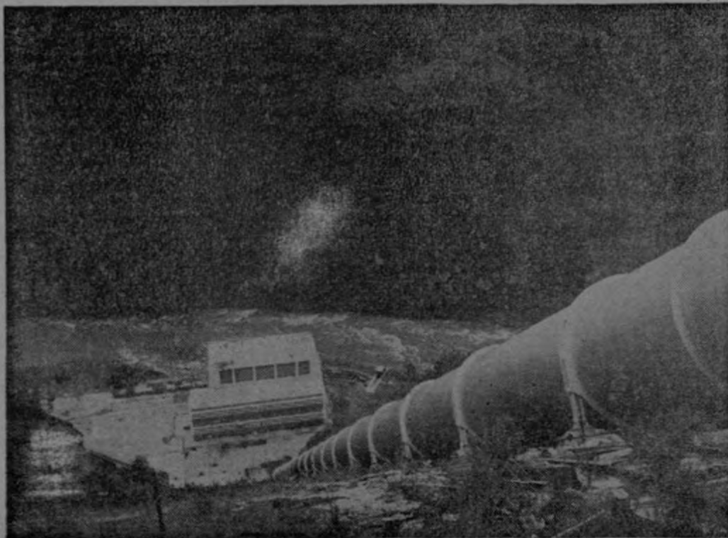
La casa de máquinas aparece al fondo de este precipicio. Este tubo de conducción lleva el agua con gran presión hasta donde están ubicadas las turbinas y generadores de la casa de máquinas. (Foto Mario Loaiza).
